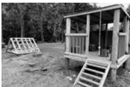
▲子ども達がか中で遊んだり、リラックスしたり、本を読んだりするクラブハウス。古い木材の電柱を支柱に活用。
